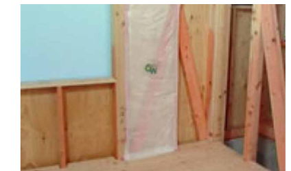
③最初に剥がした防湿フィルムをかぶせ直し、間柱の見附面にタッカーで留めて完成です。
