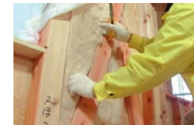
②筋交いに沿ってグラスウールに切込みを入れ、筋交いの後ろ側に押し込まれていたグラスウールを筋交いと同面になるよう手前に引き出します。
