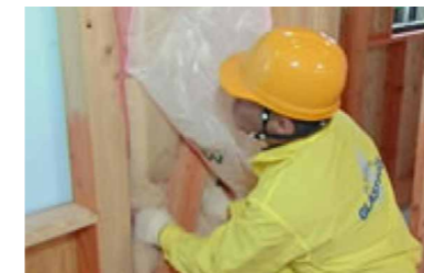
①防湿フィルムを一旦剥がし、筋交いの裏側にグラスウールを入れていきます。
