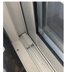
カバー工法施工後
